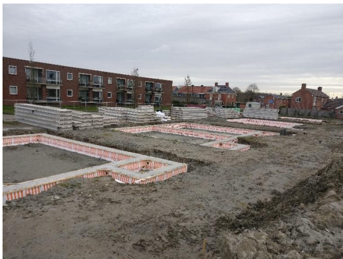
Werkzaamheden S.H. Woldringhstraat
